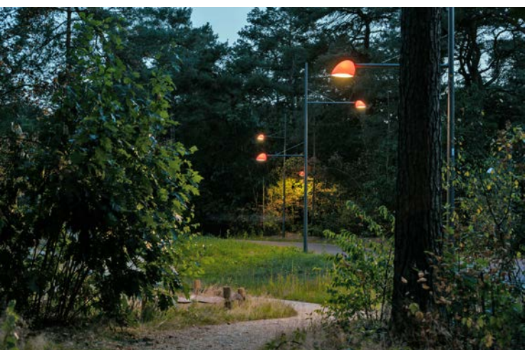
wUrck heeft op verzoek van de bewoners een terughoudende verlichting richting het bos toegepast. Witte kapjes zijn gecombineerd met rode ledlampjes. De opletende kijker ziet er een verwijzing naar het bekende sprookje in. De straat- en troitvoerlichting is in één lantaarnpaal gecombineerd om zo min mogelijk kabels te hoeven toepassen.
