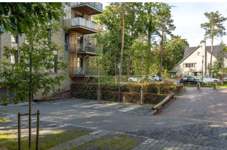
De keerwanden van de verdiepte parkeerplaatsen zijn gemaakt van BioBlocks, geperste kraggen uit natuurgebied de Weerribben-Wieden. Ze zijn afgewerkt met een cortenstalen plaat.
