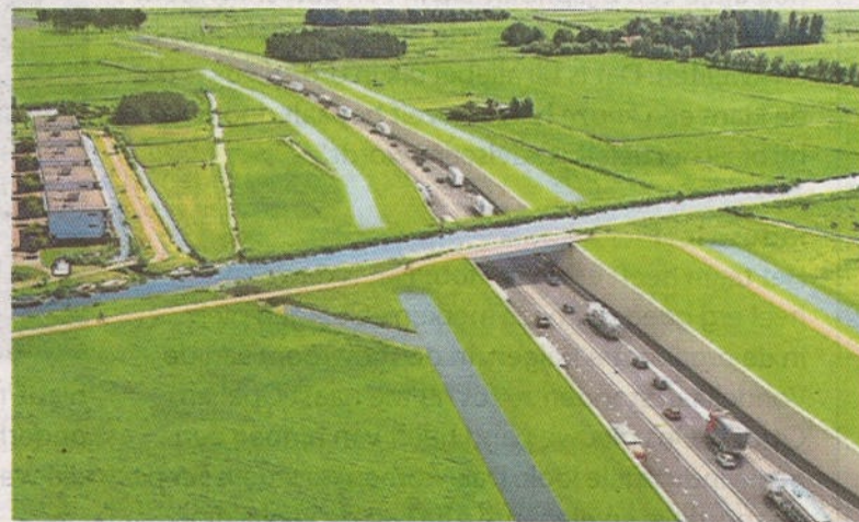
Aan weerszijden van het aquaduct van de Veenwatering krijgt de Rijnlandroute mogelijk nog een groene overkapping.
