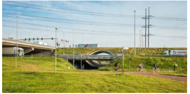
DE FIETSKATHEDRAAL VOEGT ZICH IN EEN COMPLEX EN GELAAGD INFRALANDSCHAP
