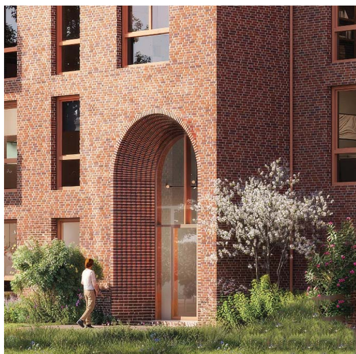
AMBACHTELIJK GETRAPT METSELWERK IN EEN RONDBOOGVORM BENADRUKT DE ROBUUSTE BOUWMASSA EN TREKT DE BLIK NAAR DE HOOFDENTREE
