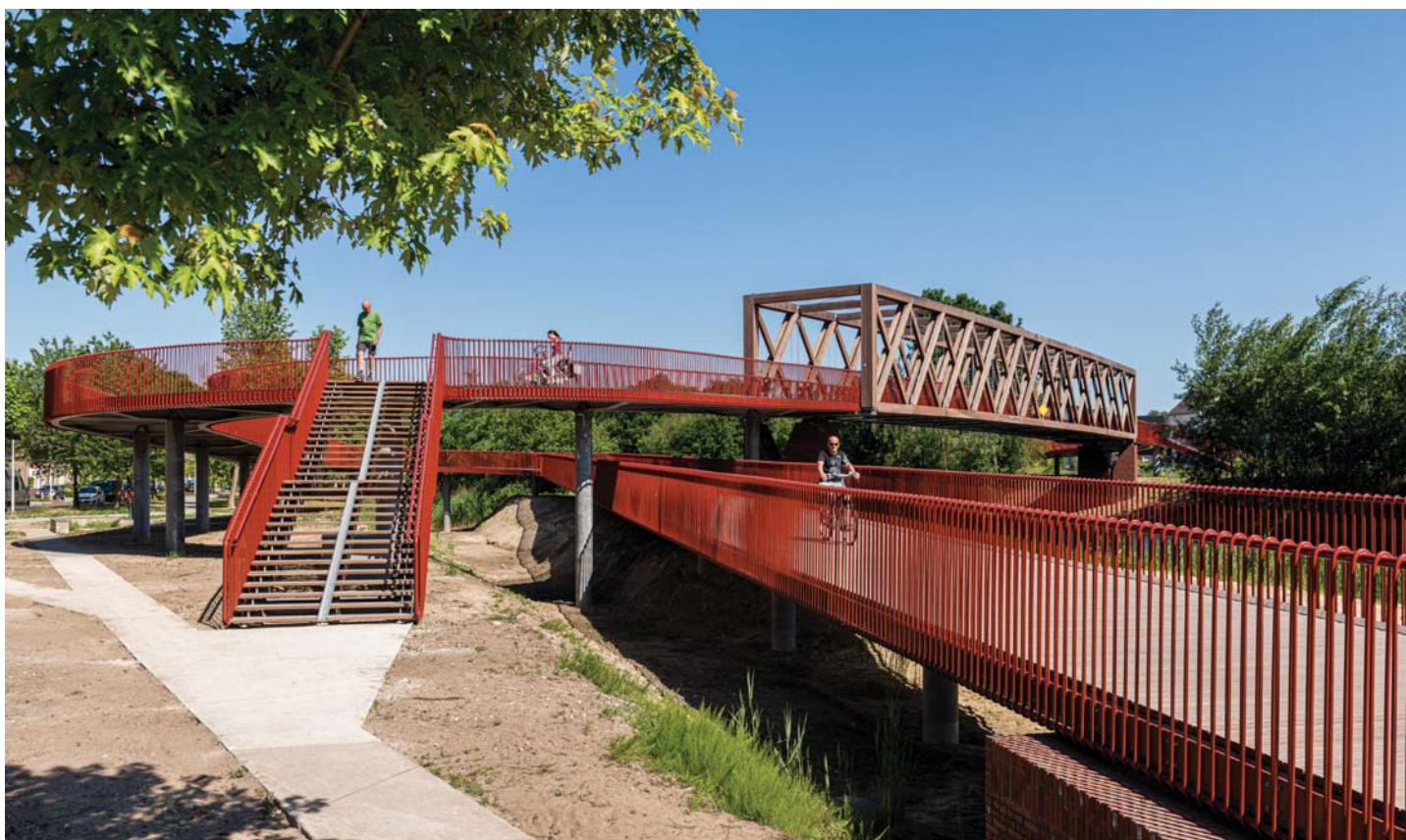
IN EEN VLOEIENDE LIJN ZWEEFT DE BRUG VAN OEVER NAAR OEVER
