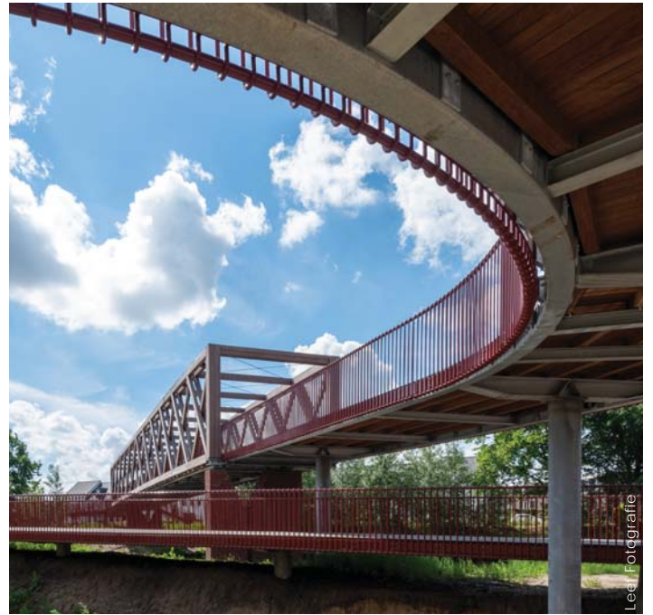
DE AANBRUGGEN WORDEN DOOR EEN GEGALVANISEERDE STALEN CONSTRUCTIE ONDERSTEUND
