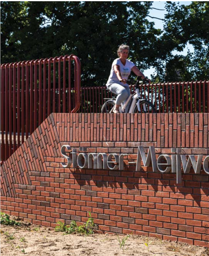
AMBACHTELIJK EN ROBUUST GEDETAILLEERDE AANLANDINGEN
