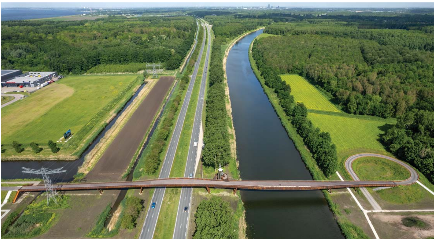
DOOR KENMERKEN VAN HET LANDSCHAP OVER TE NEMEN WORDT DE BRUG ZELF EEN LANDSCHAP. DE AANLANDING OP DE NOORDOEVER IS EEN STILLE VERWIJZING NAAR HET SPIRAALVORMIGE PAD VAN ALMERE BOVEN, DAT LEIDT NAAR HET DERTIG METER HOOG GELEGEN MONUMENT VOOR DE FOUNDING FATHERS
