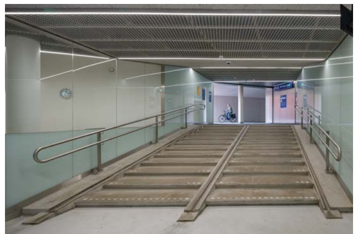
DE BEHEEDERSRUIMTE BIEDT ZICHT OP DE ENTREEZONE
