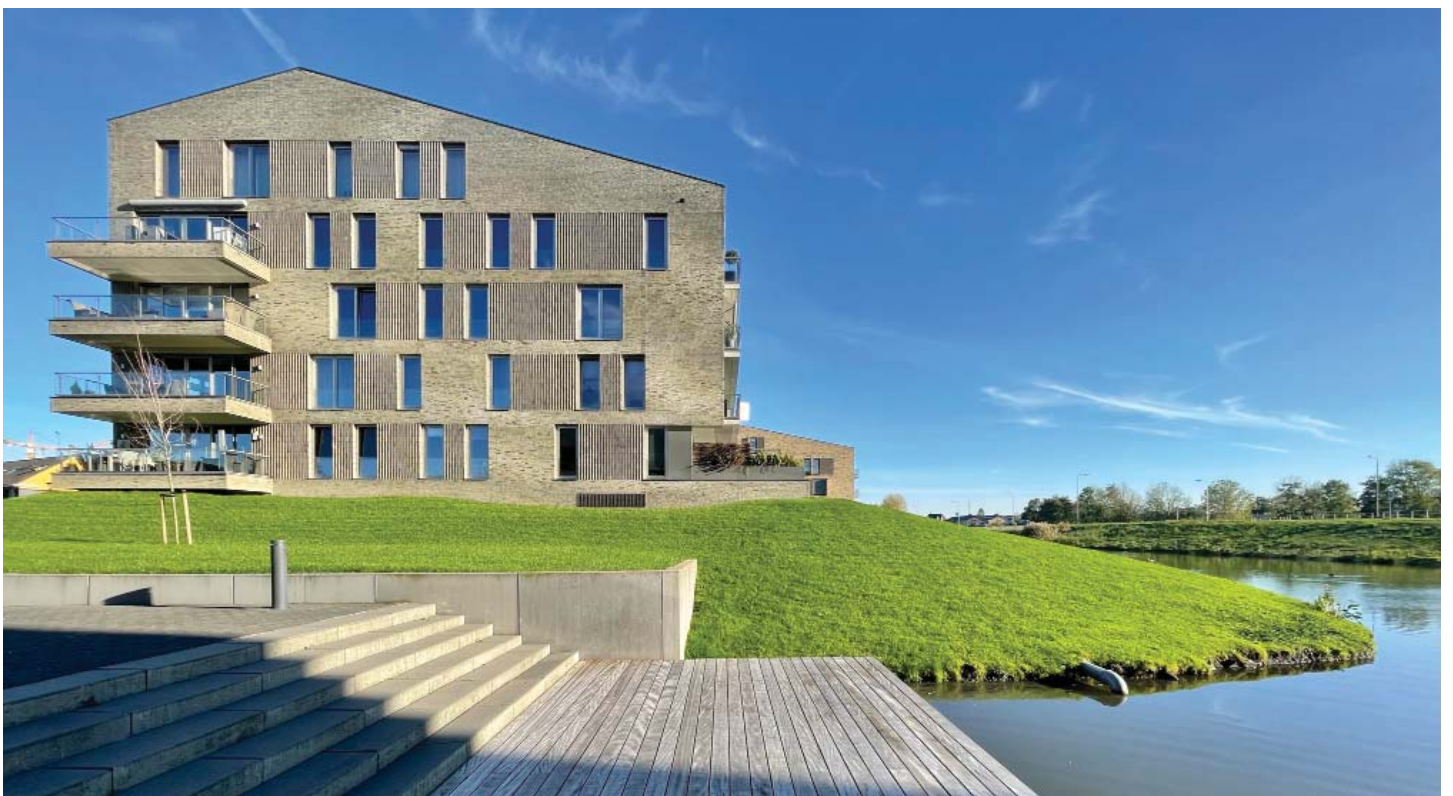
PIER 3 IS GESITUEERD OP EEN GLOOIING IN HET LANDSCHAP DIE HET PARKEREN AAN HET ZICHT ONTTREKT
