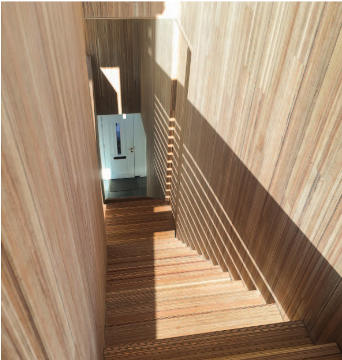
DETAILLERING IN VERLIJMD KOPS- EN LANGSHOUT
