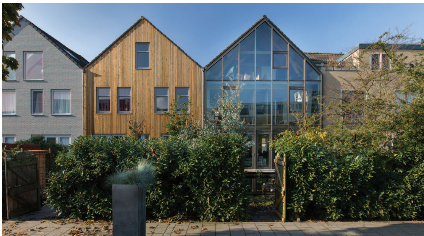
DE ACHTERGEVEL IS VOLLEDIG VERVANGEN DOOR EEN VLIESGEVEL
