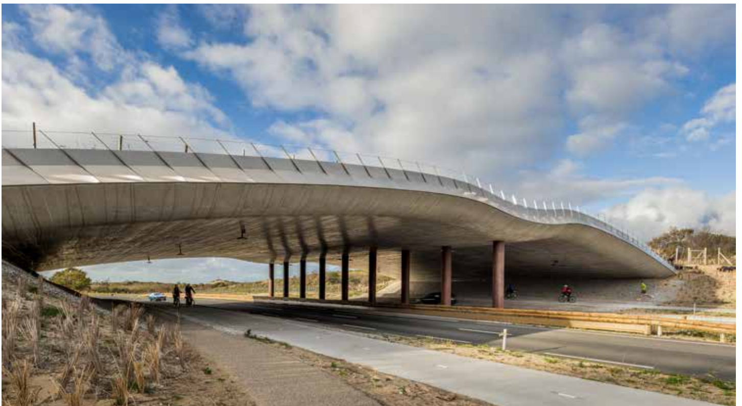
BETONDEK GEDRAGEN DOOR HET DUIN
