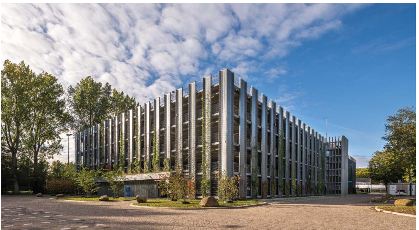
HET HOOFDTRAPPENHUIS IS HET ENIGE ELEMENT DAT BUITEN HET VOLUME VAN DE PARKEERGARAGE IS GELEGEN; VOETGANGERS KRIJGEN HIERDOOR REEDS BIJ HET VERLATEN VAN DE GARAGE OVERZICHT OVER DE OMGEVING
