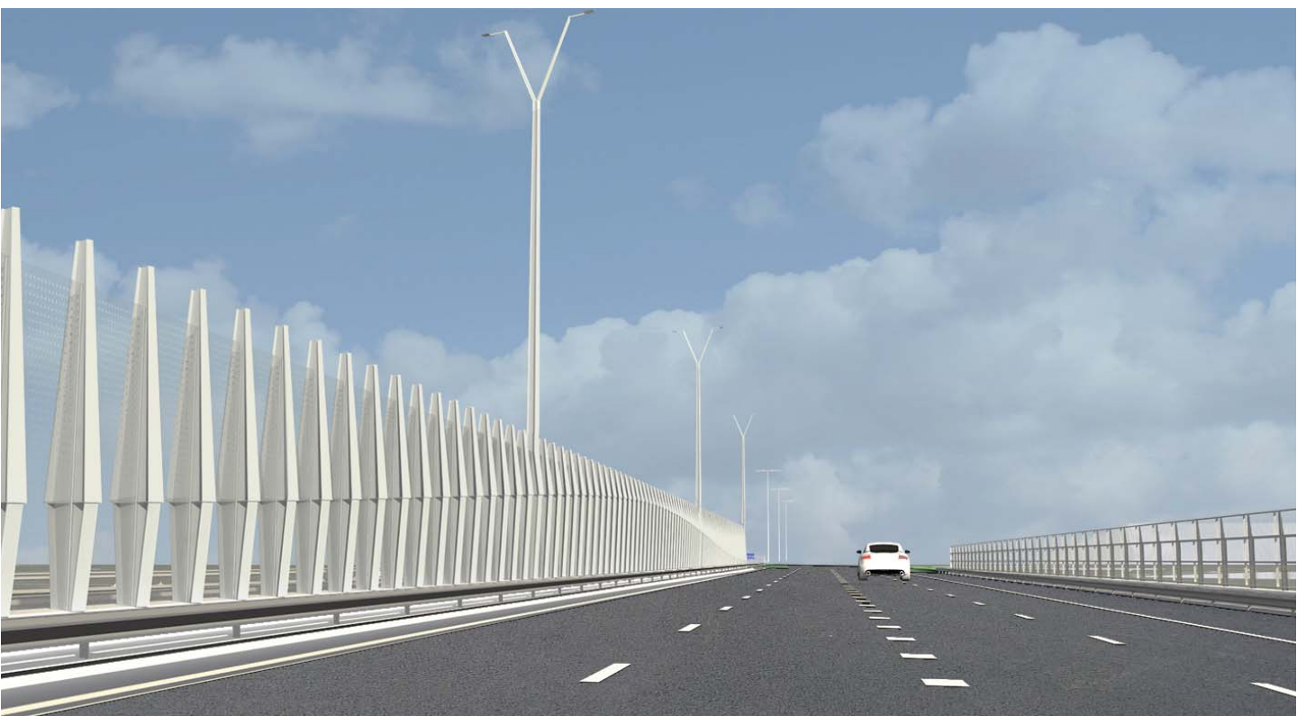
HET MIDDEN-GELUIDSSCHERM OP DE BRUG OUDE RIJN ACCENTUEERT DE PASSAGE OVER DE OUDE RIJN. IN HET SCHERM ZIJN DE LICHTMASTEN GEÏNTEGREERD VORMGEGEVEN
