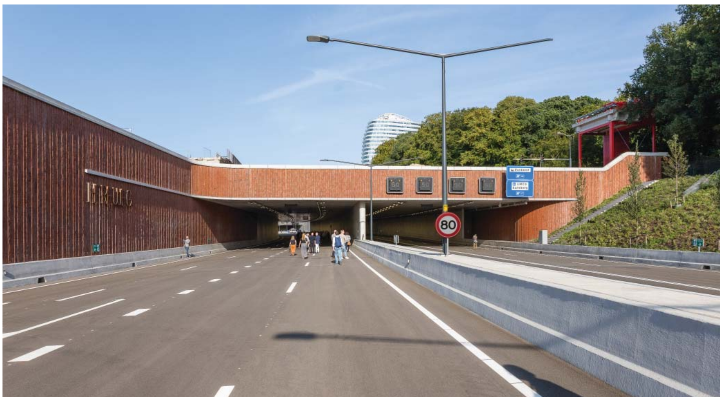
DE TOERITTEN ZIJN MET ZORGVULDIG GEDETAILLEERD GRONINGER METSELWERK BEKLEED
