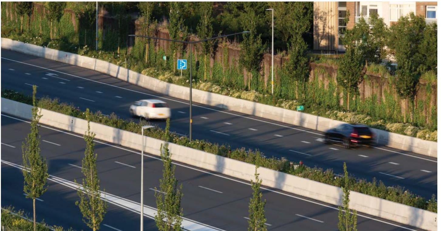
HET PARKWAYPROFIEL BESTAAT UIT VERHOOGDE MET ROZEN EN ZUILIEPEN INGEPLANTE BERMEN EN SPECIALE LAGE LICHTMASTEN
