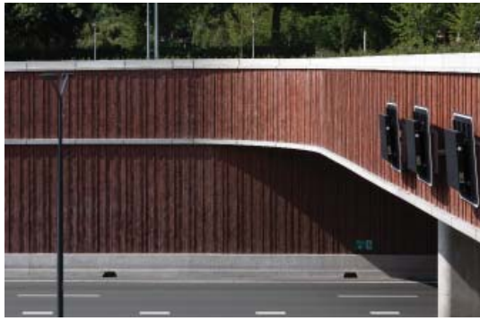
HET METSELWERKVLAK KROMT ZICH OM DE TOERIT HEEN
