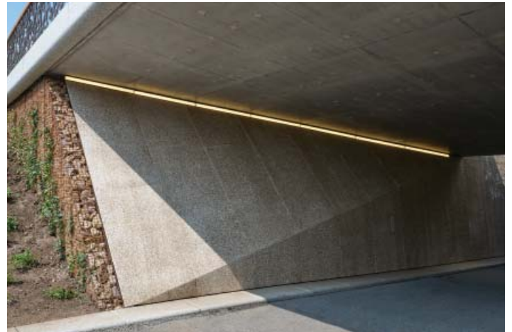
DE ACHTEROVERHELLENDE WAND OPENT DE ESPERANTOTUNNEL
