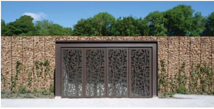
DE MET ROZENPATTERNHEKWERKEN AFGEWERKTE VLUCHTRAPPENHUISJES
