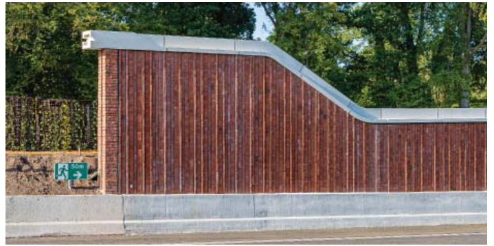
BËËÏNDIGING VAN DE METSELWERKWANDEN TER PLAATSE VAN DE TOERITEN
