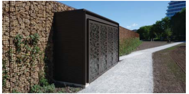
DE MET ROZENPATROONHEKWERKEN AFGEWERKTE VLUCHTRAPPENHUISJES
