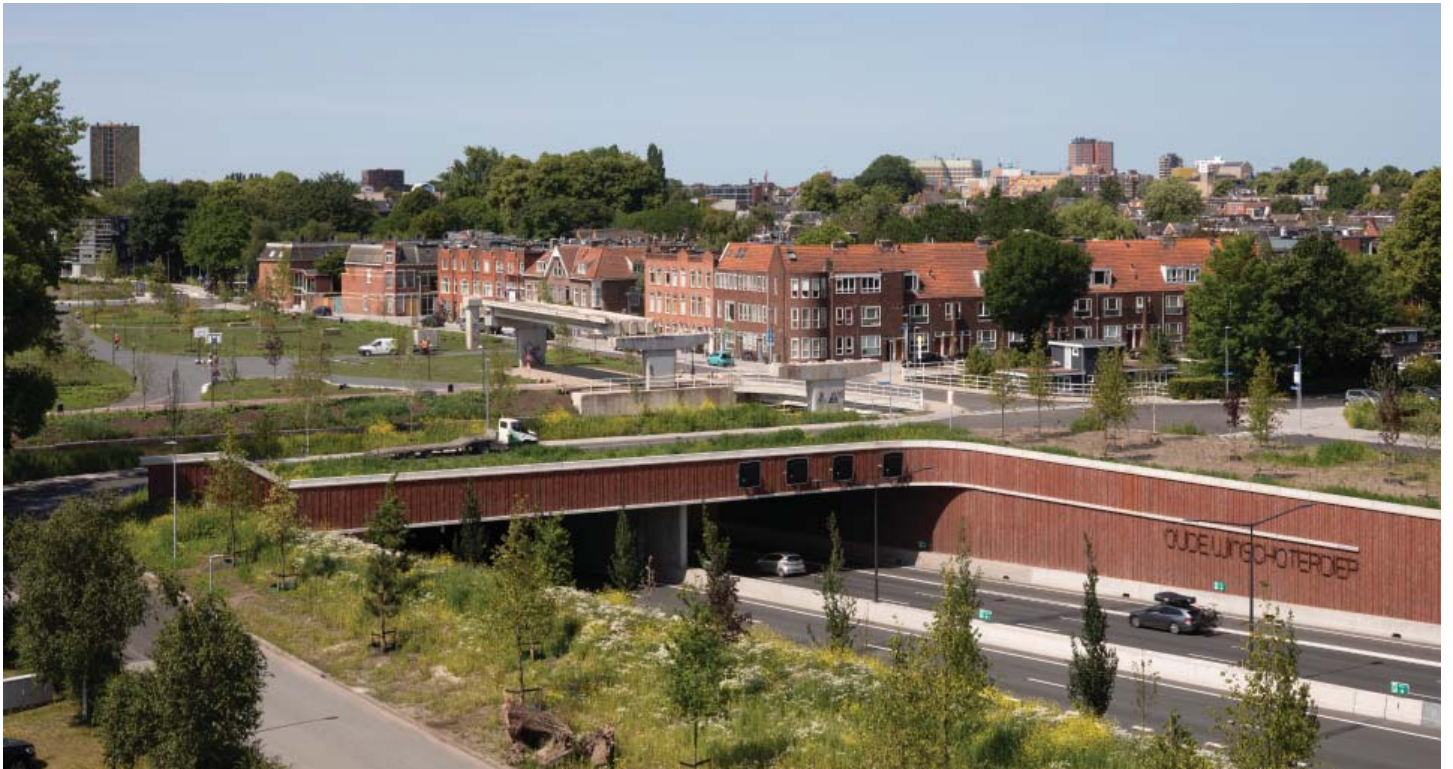
DE OOSTELIJKE TOERIT VAN DE VERDIEPTE LIGGING, DE RINGWEG DUKT HIER ONDER HET OUDE WINSCHOTERDIEP, MET OP DE ACHTERGROND DE RELICTEN VAN DE OUDE WEG
