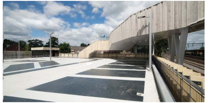
DE HOUTEN LAMELLEN VAN DE SPOORGEVEL ZIJN FAMILIE VAN DE HOUTEN BEKLEDING VAN DE VOETGANGERSPASSERELLE
