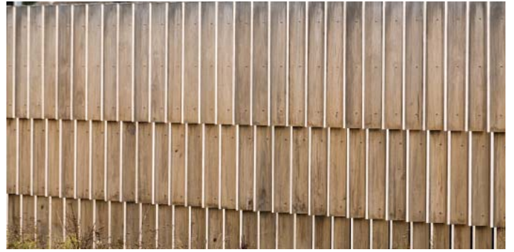
DETAIL VAN DE HOUTEN LAMELLEGEVEL
