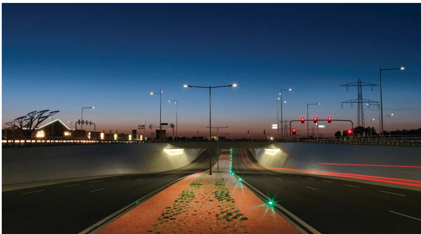
DE LED-LIJNEN WERKEN 'S AVONDS ALS ACTIEVE WEGMARKERING
