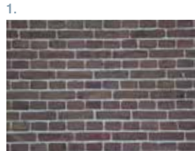
1. Landhoofd metselwerkverband conform type Woudagemaal
