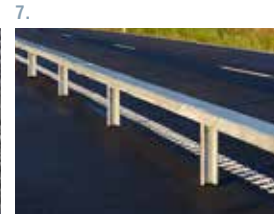
7. Geleiderail, Birsta 1P thermisch verzinkt en gepoedercoat
