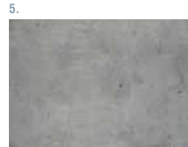
5. Constructie onderbouw gladbekist, zichtbeton
