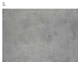
5. Constructie onderbouw gladbekist, zichtbeton
