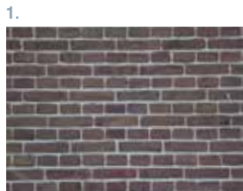
1. Landhoofd metselwerkverband conform type Woudagemaal
